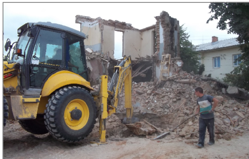
Muncitorii demolează vechea construcție, pe locul căreia se va ridica noua clădire administrativă
